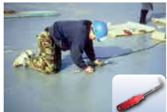
fig. 2: Kontroll av sveiseskjøter
